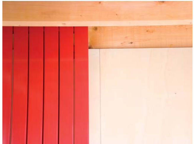
Petite note de couleur, qui n'est pas sans rappeler la paroi coulissante de l'entrée et les bardages de façades, ce long radiateur électrique n'est utilisé que lorsque la cheminée n'est pas en fonction.
