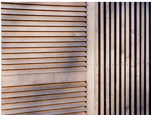
Le bardage vertical de la cuisine d'appoint ainsi que les coulissants de ses ouvertures ont déjà perdu leur teinte miel au profit de cette couleur argentée tellement caractéristique des bois qui vieillissent en extérieur.
