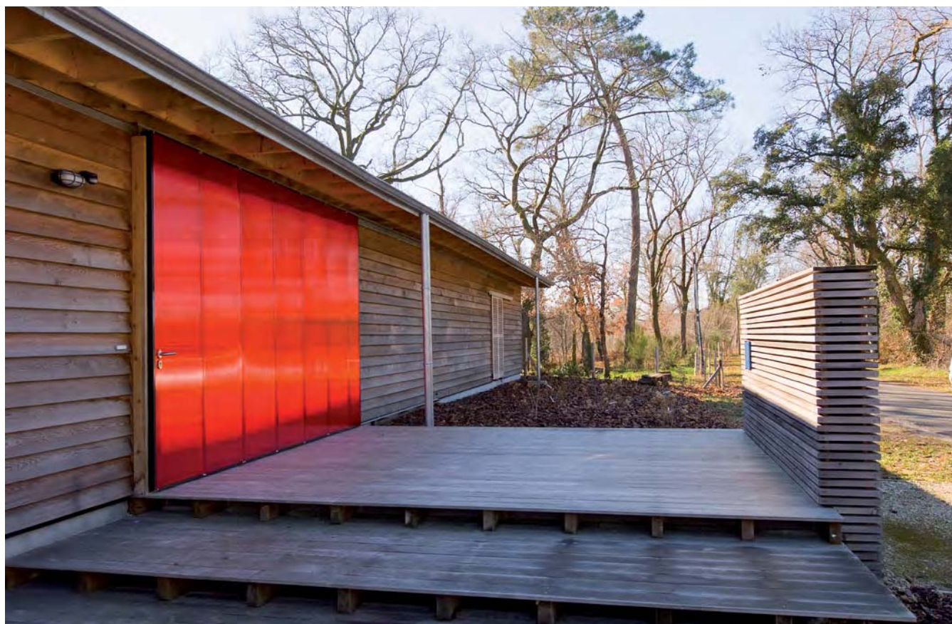
La terrasse démarre à l'extérieur de la maison, un peu à l'image d'un parvis dissimulé derrière un mur de parpaing habillé de mélèze posé à claire-voie.
